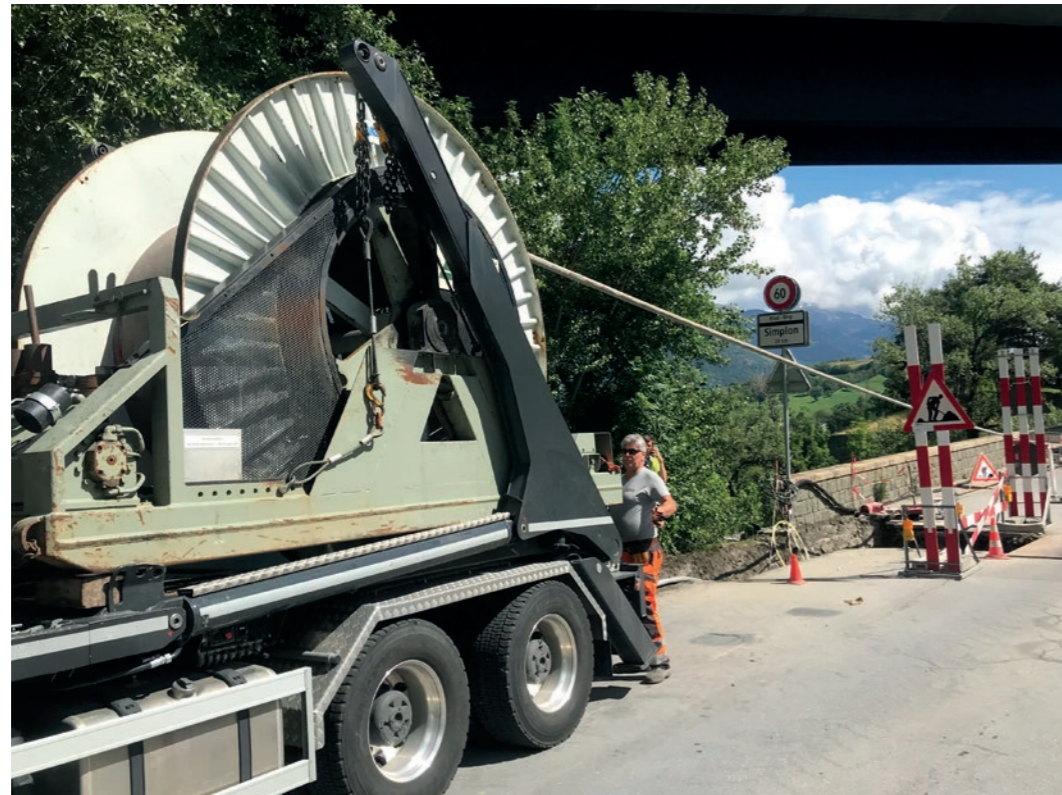
Netzbau bei der Napoleonsbrücke: Kabelzug mit Spezialgerät
