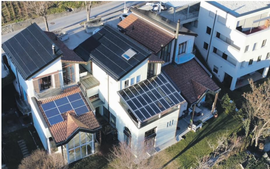
Die Dächer sind unterschiedlich ausgerichtet. Dadurch fangen die Fotovoltaik-Module über den Tag hinweg möglichst viel Sonnenlicht ein. Bild: zvg
