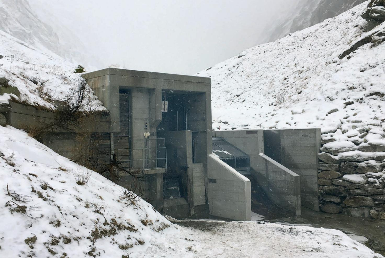
■ Fassung Gredetsch: Optimierung mittels Coanda-Rechen und Spülklappe
