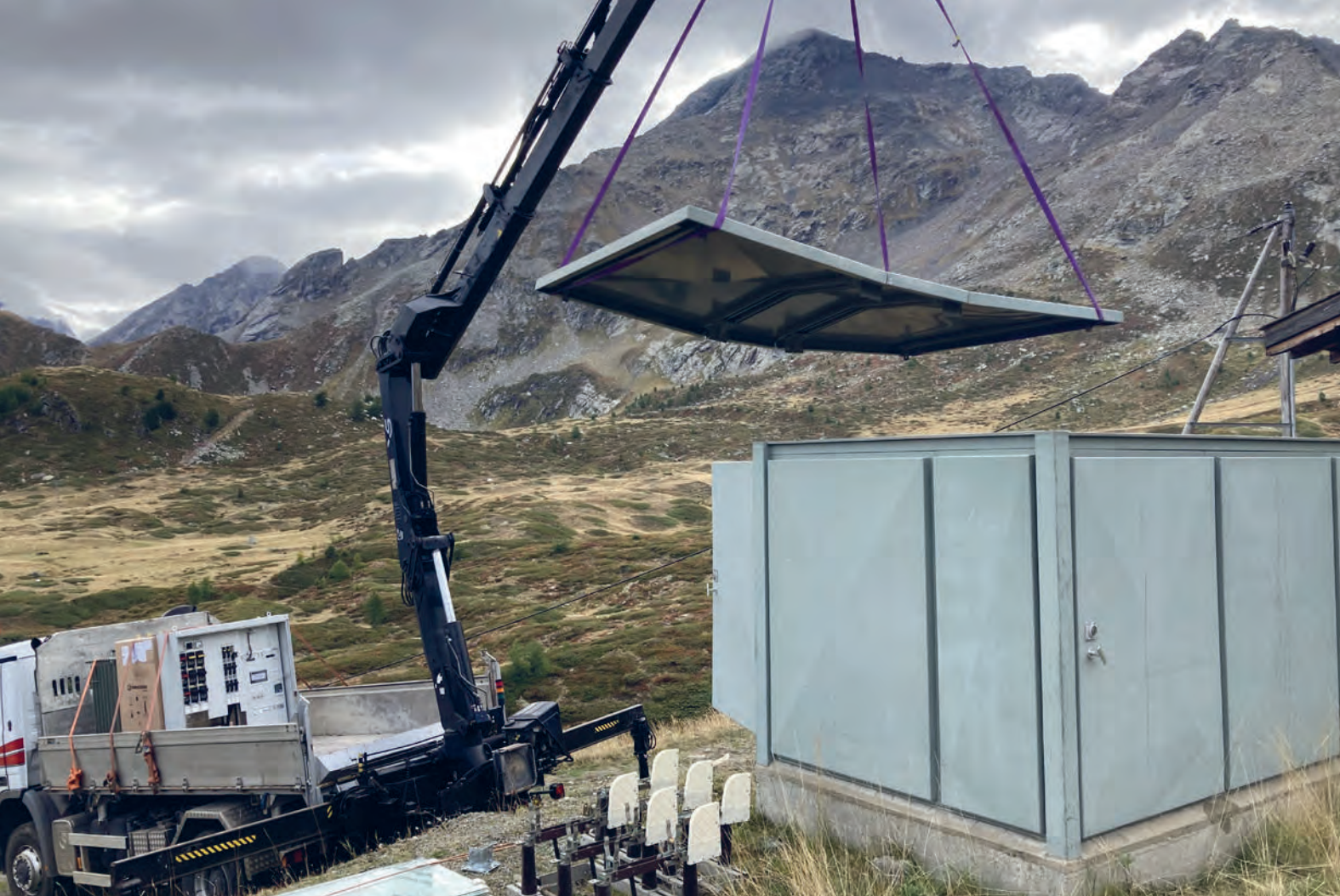
■ Erneuerung TS Skilift Bodmen
